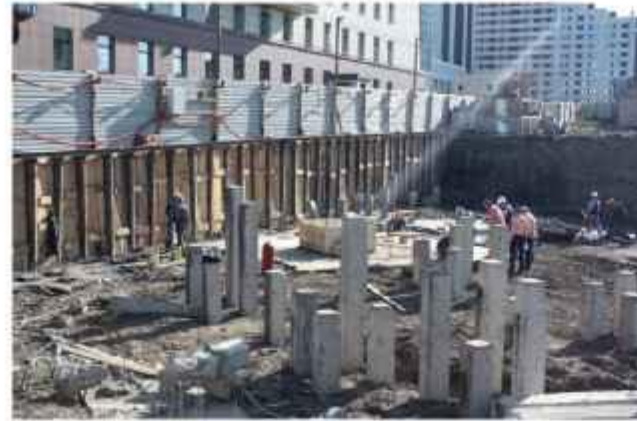
Строительная площадка. 19.06.2019 год
