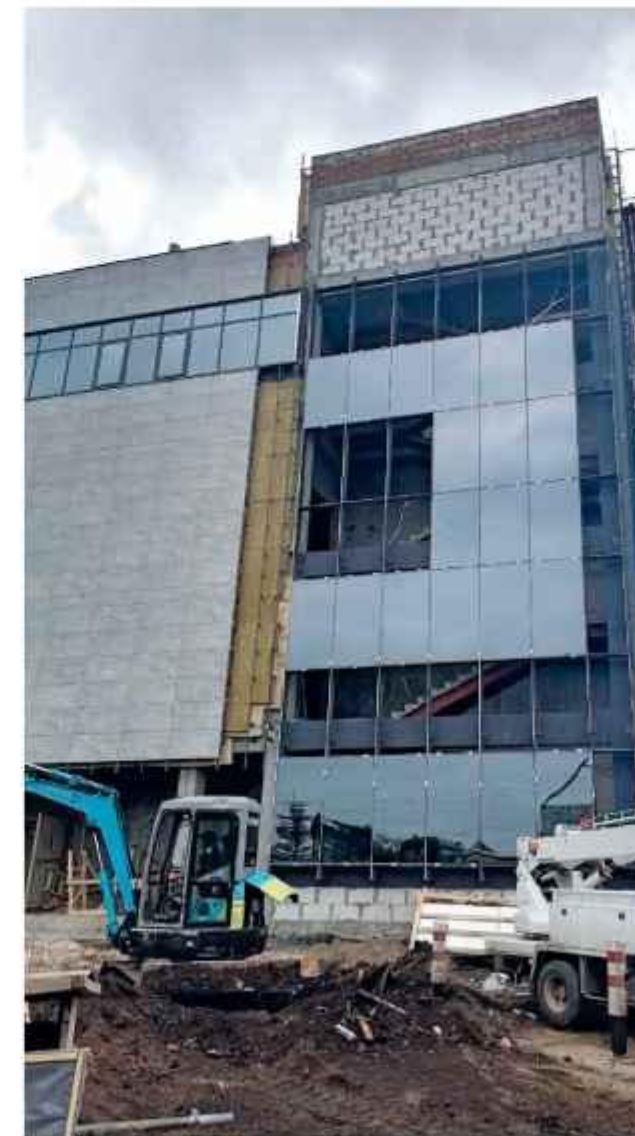
Строительная площадка. 20.10.2021 год
