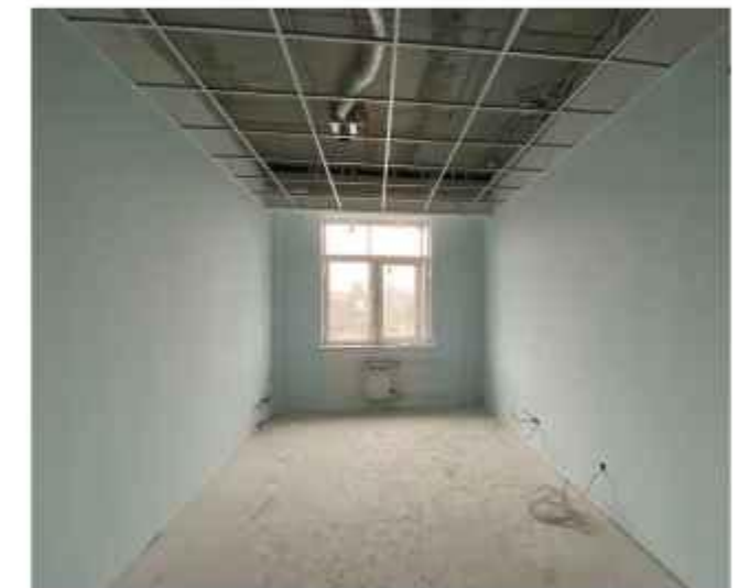
Кабинет судьи, подготовленный под чистовую отделку
