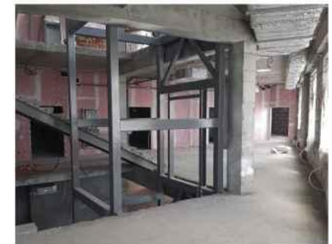
Строительная площадка. Внутреннее помещение
