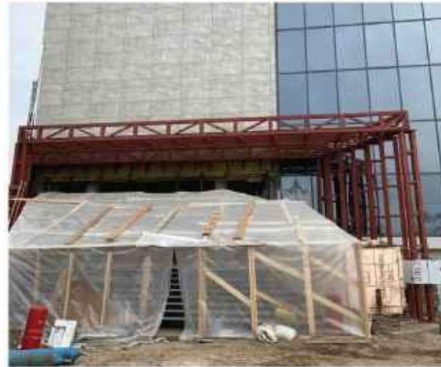
Строительство крыльца и входной лестницы
