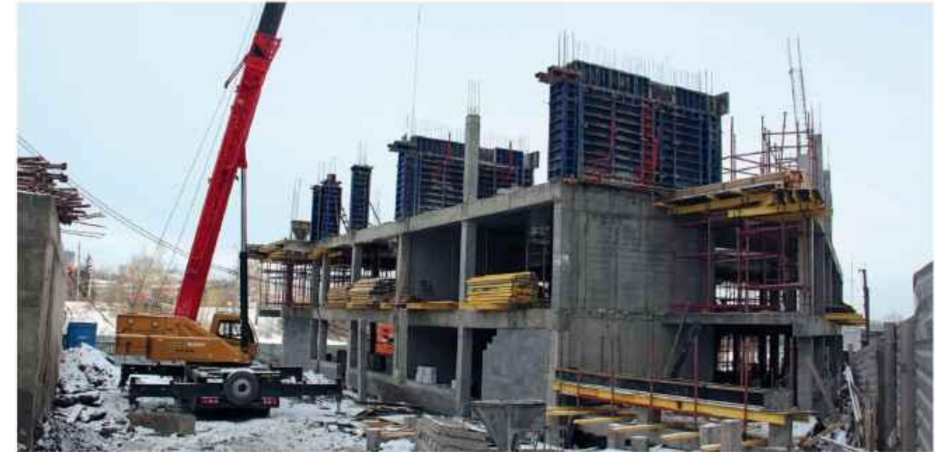
Строительная площадка. 20.11.2019 год
