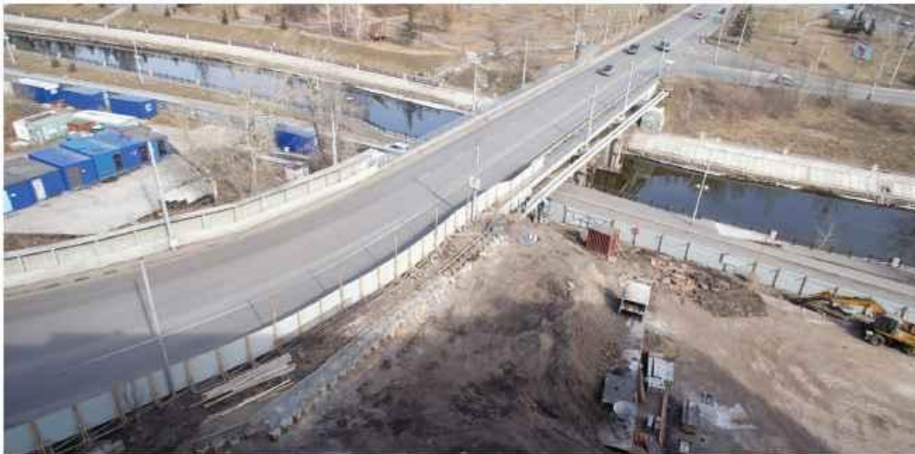
Строительная площадка. Вид сверху 2018 год
