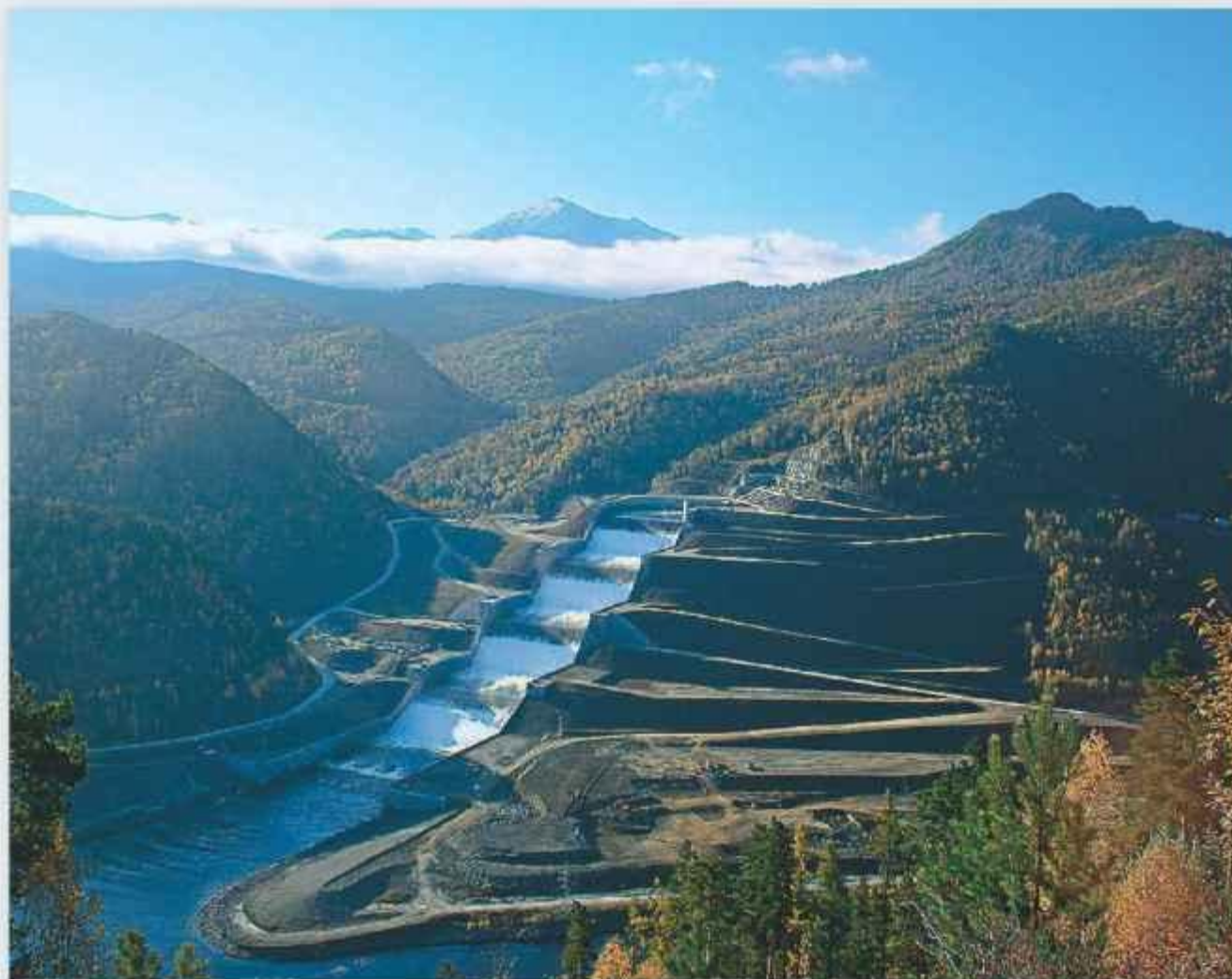
Водосброс Саяно-Шушенской ГЭС
